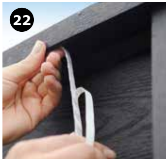
22 LED ledningen klistres på indvendig topprofil. For yderligere fastgørelse, brug montage lim.
