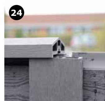
24 Kirkedal Topprofil sættes på så den "fanger" toppen af profilerne samt topklods som er monteret øverst i stolpen. Samling af topprofil gøres midt på stolperne.
