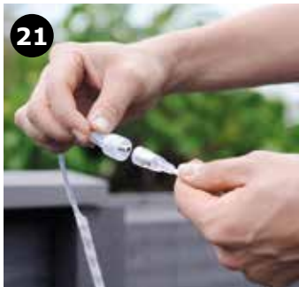
21 Samling af Kirkedal LED lys gøres nemt og er vandtæt. I stedet for synlige samlinger midt på hegnet, kan samlingerne med fordel gå ned i stolpen. Kirkedal LED-lys SKAL monteres af en autoriseret elektriker. TreeTops A/S tager ikke ansvar for montering og/eller skader som følge heraf.
