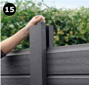
15 Vent med at sætte den sidste profil i stolperne, da der først skal sættes K11 Topklods i toppen af stolpen.
