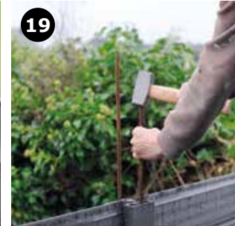
19 Hvis dit hegn sættes op i særligt udsatte områder, sæt da tentorstål ned igennem stolperne og fyld tørbeton i midten af stolperne. Dette foreskrives også ved hegn der er højere end 1,7 mtr.
