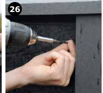
26 Husk at skrue en skrue i hver ende af profilerne, dog ikke på begge sider af hegnet. Dette for at støtte vægten af profilerne.
